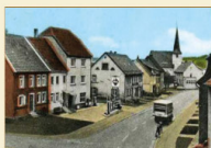
Alte Synagoge in Tautsch Nutzung der Synagoge als Tankstelle
